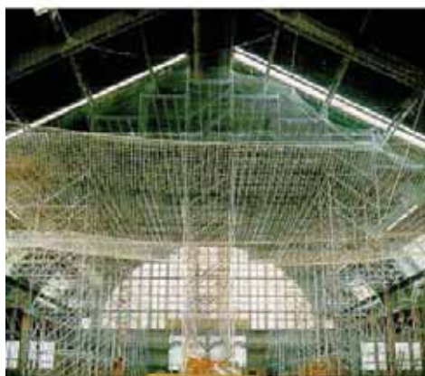
Fig. 9.2.3-2 Esempio di utilizzo di un sistema S (coperture di grandi capannoni industriali)
